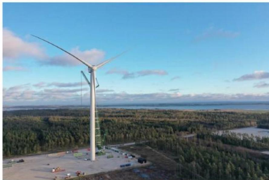
据西门子歌美飒项目团队介绍，2月3日完成了第三支叶片安装，目前正在整机系统测试，不久后将投入运行。去年11月26日，在哥本哈根举行的2019欧洲海上风电展览会上西门子歌美飒重磅发布11MW海上机型，型号SG11.0-193DDFlex，采用西门子B94叶片（注：该叶片制造采用西门子独有的IntegralBlade®专利技术），叶轮直径193米，该机型是基于10MW平台，在特定条件下进行功率提升达到11MW。风场位于丹麦Osterild国家试验风场，首台商用SG 11.0-193 DD机组将安装在瑞典大瀑布公司位于荷兰的Hollandse Kust South 1-4号风场，该风场也是世界首个无补贴海上风场。
