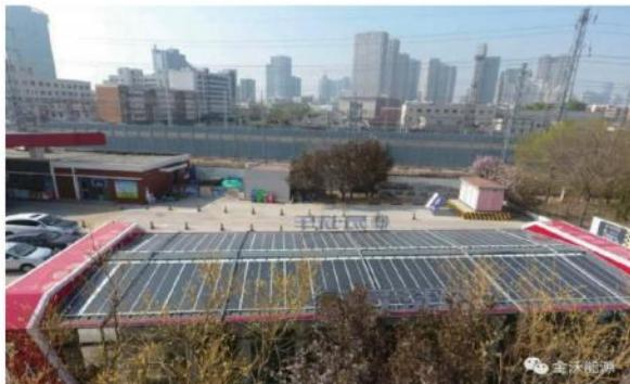
该项目所采用的柔性光伏组件，安装在该中石化加油站所属的独立钢玻结构建筑的屋顶，单组组件产品规格峰值功率120Wp，项目装机容量10KW。所发电能主要用于该加油站日常办公用电，满足自发自用，余电上网。
