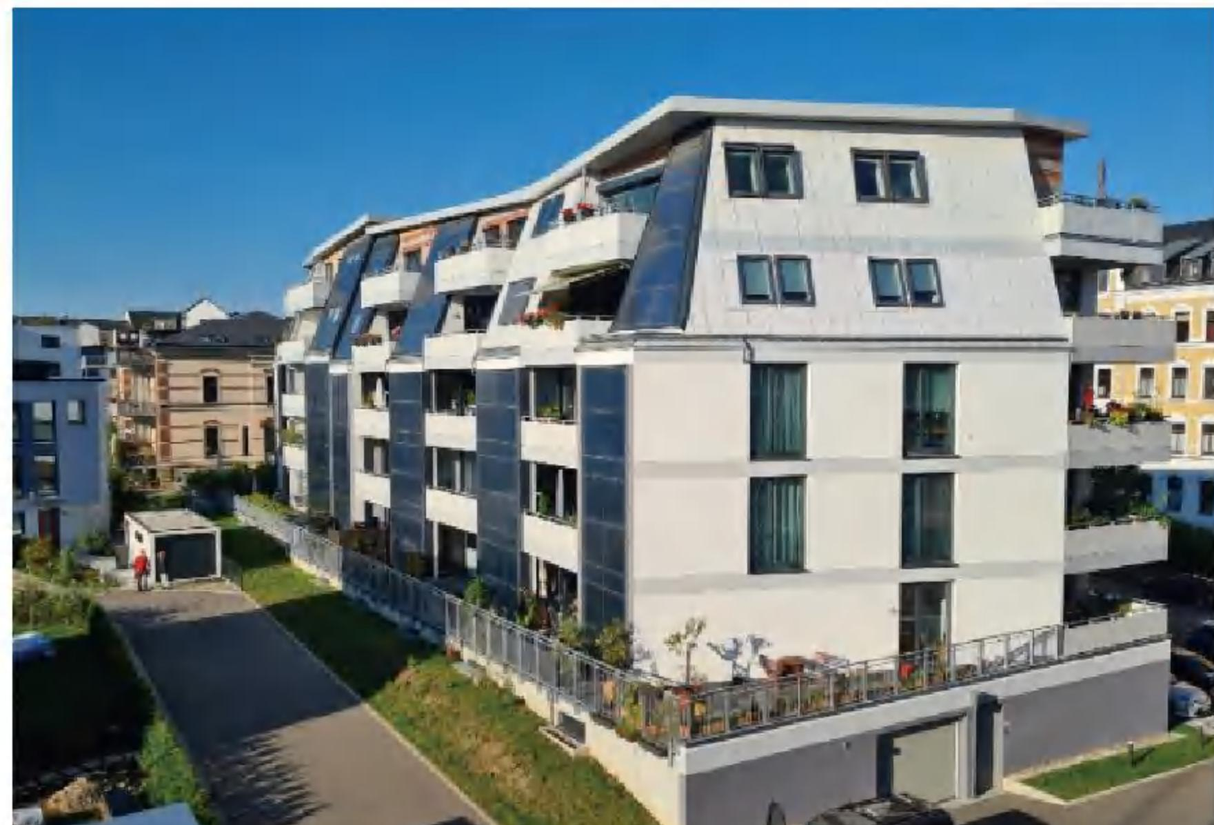
Solardomizil I 和 II,其中太阳能集热器已集成到立面上,一个 200 立方米的储罐将热量储存在建筑物内。与安装传统供暖相比,太阳能热的使用使建筑成本增加了约 100 欧元/m<sup>2</sup>建筑面积。但太阳能系统也将在未来很长一段时间内提供低廉、稳定的能源价格。
