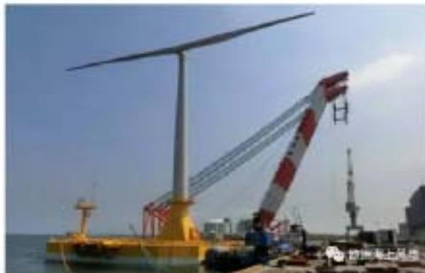
其传动系统包括一个独立的转子轴承、一个两级行星齿轮和一台发电机。具有重量轻、体积小、建设重量成本低、效率高等优点，更适合于海上风电。德国Aerodyn公司其陆上机型主打2.5MW到3.5MW，采用上风向技术；海上机型容量从6MW到8MW之间，采用下风向技术。其中8MW机型叶轮直径达168米。这里使用的Ideal浮式基础，它在大阪Sakai造船厂建造，面积36平方米，深10.8米，由加强和预应力混凝土制成。日本风能协会主席Yoshinori Ueda表示，这是一项全新技术，存在一定的风险，但减轻风机和基础质量可有效降低海上风电成本，是值得尝试的。
