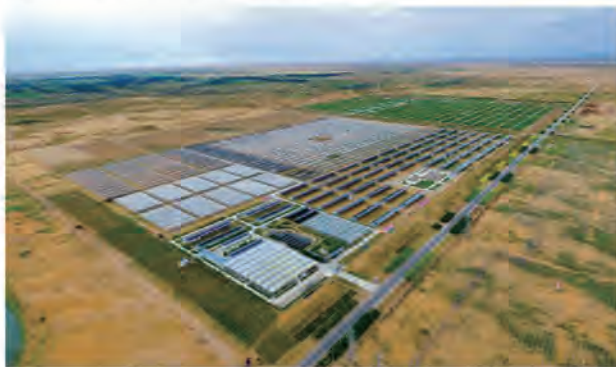
华盛绿能磴口光伏农业园区航拍
