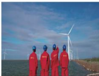
山东黄骅风电现场
