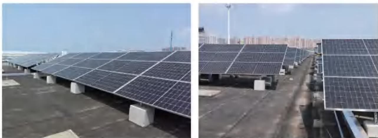
该项目是天津汇和新能源有限公司继冠成钢厂厂房79.65kW分布式光伏发电项目、海润天通华阳热力调峰站77.76kW分布式光伏发电项目之后，承建的第三个分布式光伏发电项目。该项目于2022年5月7日开始施工，2022年7月13日完成并网带电调试。该项目采用550Wp单晶硅电池组件，总装机容量为772.2kW。采用“自发自用，余电上网”模式，所发电量就近消纳后，多余电量上传至电网。该项目利用建筑物屋顶建设，在不破坏原有建筑结构及防水性能的基础上，充分利用太阳能进行发电，节约建筑物用电成本。
