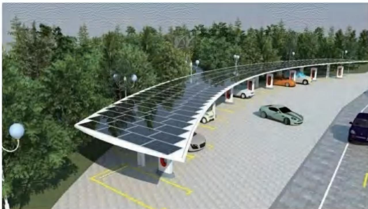
光储充一体化电站作为一种新能源微网系统，可以为充电设施企业提供持续的绿色电力。通过能量存储和优化配置，光储充一体化电站能实现本地能源生产与用能负荷基本平衡，在电价较低的谷期利用储能装置存储电能，在用电高峰期使用存储好的电能，避免直接大规模使用高价的电网电能，可以降低企业运营成本。一方面缓解了充电高峰时大电流对区域电网的冲击，另一方面通过峰谷差价，给充电站带来了可观的收益。
